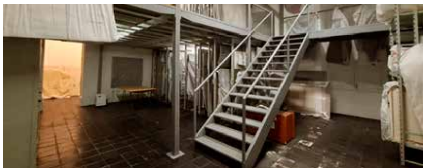
Figura 2. Reserva técnica de Artes Visuais, com estrutura de mezanino em ferro. Museu do Estado do Pará. Foto: Renata Maués.
