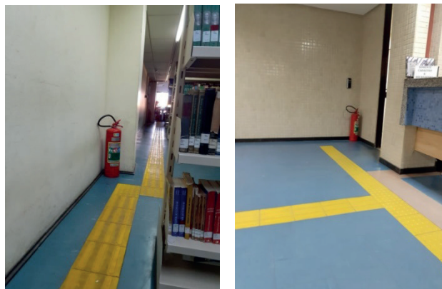
Figura 15: Vista do posicionamento inadequado dos extintores de incêndio na biblioteca central.
