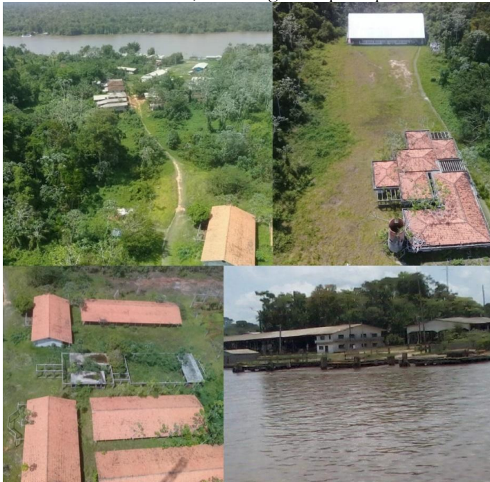
Figura 32 – Imagens de obras estruturantes paralisadas na Vila Mainardi: creche, escola e ginásio poliesportivo
