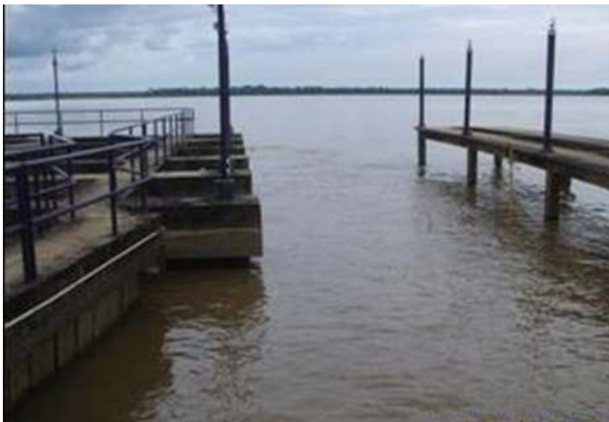
Figura 10 – Captação de água superficial – Rio Guamá.
