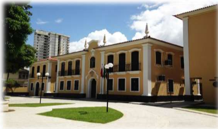
Foto 03 – Fachada atual da sede do IECG
