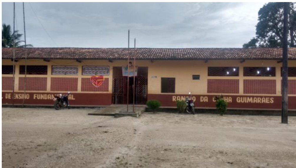
Figura 2 - Fachada da Escola Ramiro da Cunha Guimarães, Comunidade do Arimbu, município de Bragança-PA.
