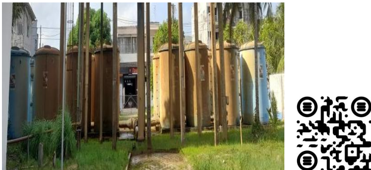
FIGURA 2 – Filtros Ascendentes. Ao seu lado, o QR code que possibilitará a visualização dos filtros ascendentes em realidade aumentada.
