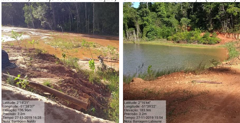
Figuras 6A e 6B – Fotografias de rejeitos de mineração, depositados na Barragem Naldo 2, no Distrito do Lourenço (à esquerda); e da Barragem Labourie, de rejeitos de mineração, no Distrito do Lourenço (à direita)
