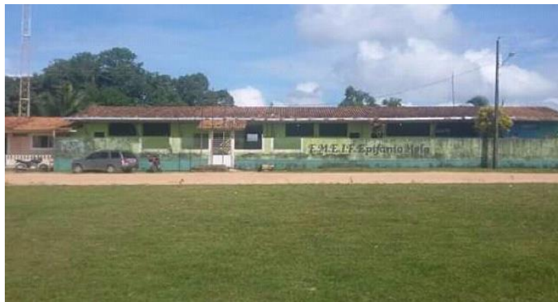
Figura 1 - Fachada da Escola Municipal Epifânio Melo Fonte, Tracuateua-PA.
