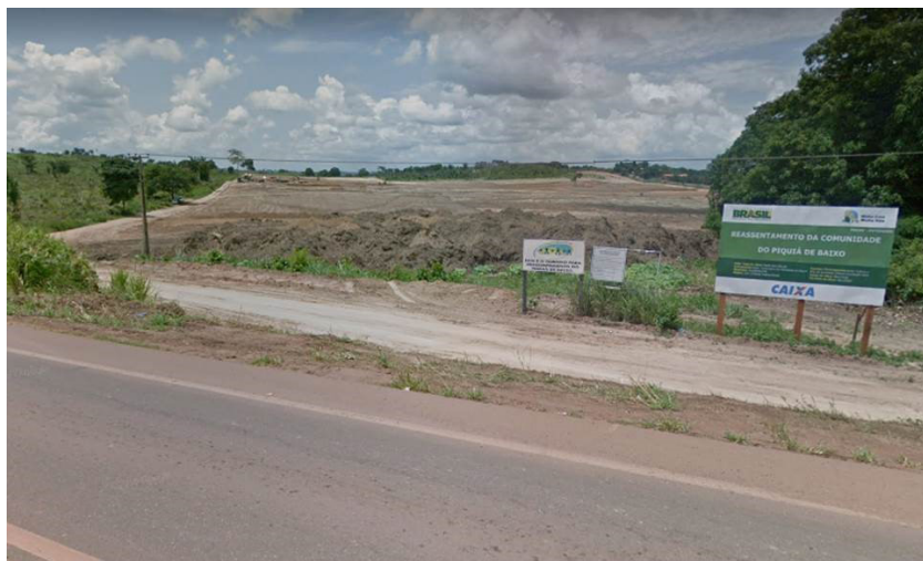
Figura 12. Terreno para construção do bairro Pequiá da Conquista, reassentamento de Pequiá de Baixo, serviço de terraplanagem já realizado
