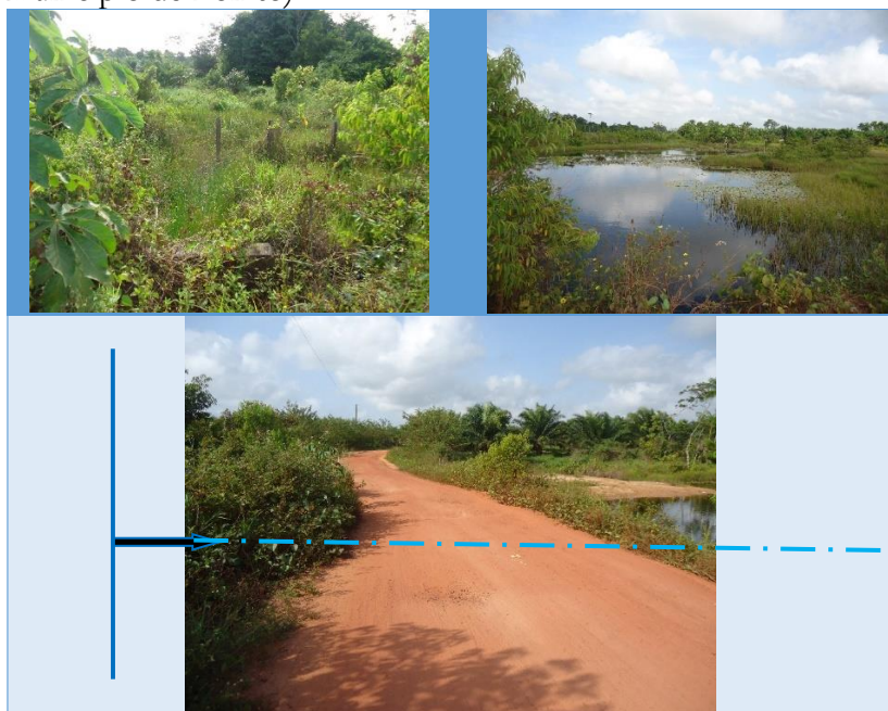
Figura 19 – Interceptação de rio em trecho da rodovia PA-322 (no município de Bonito)
