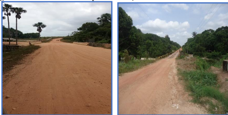
Figura 17 – Rodovias sem pavimentação
