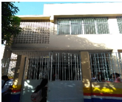
Figura 5 – Fachada da escola Dr. Freitas.
