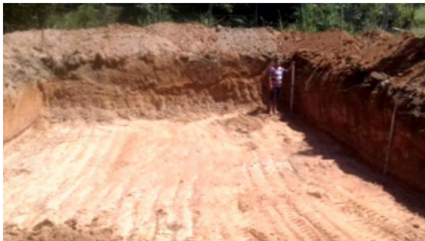
Figura 5 – escavação de tanque para a criação de tambaqui
