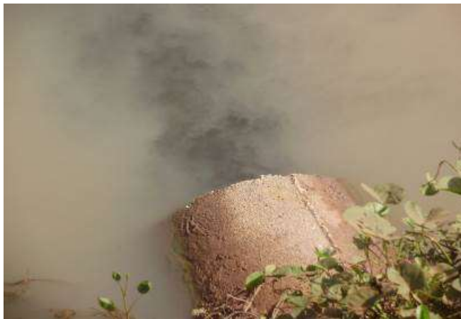
Figura 08: Sistema de bombeamento da água para a plantação
