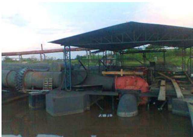
Figura 06: Bombas que retiram água do Rio Arari para o plantio de arroz Fonte: Pesquisa de campo (2013)
