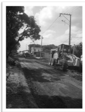
Obras de ampliação da via de acesso ao Bairro do Icuí-Guajará – Jun. 2010
