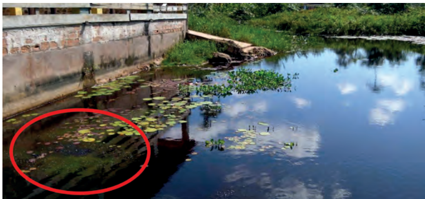
Figura 8: Presença de bioindicadores no rio
