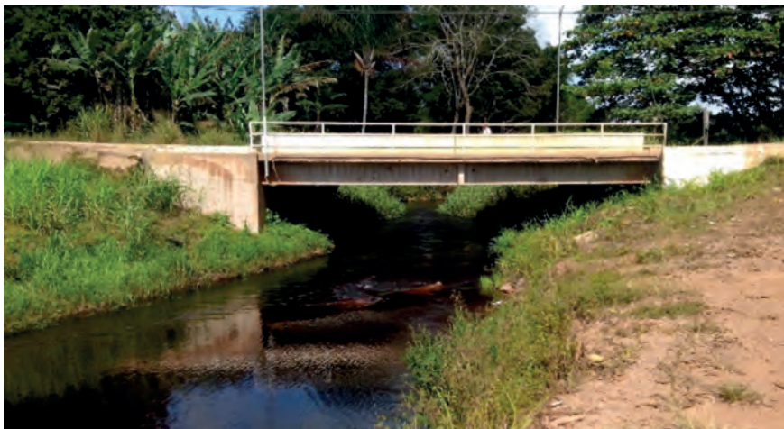
Figura 6: Ponte que interliga o centro do município à área rural do mesmo
