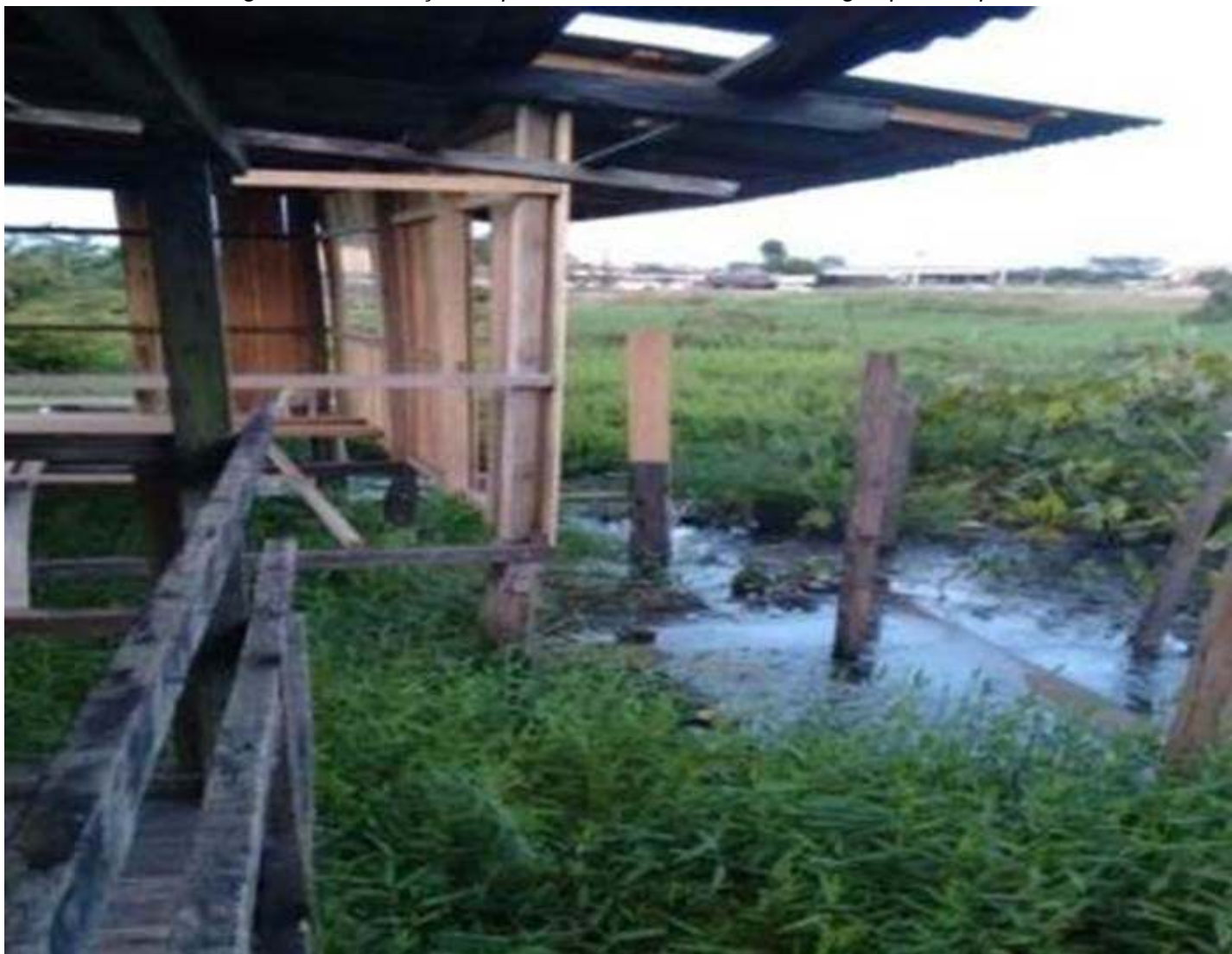
Figura 11: Construção de ponto comercial no entorno do Igarapé Sucupira
