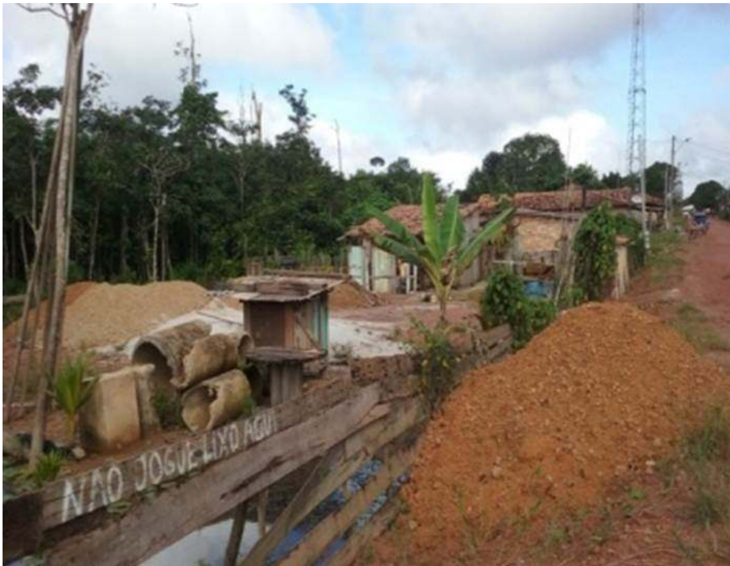
Figura 4: A margem do Igarapé Sucupira sendo aterrado e virando depósito de materiais de construção
