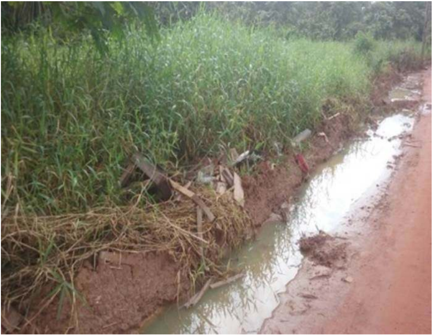
Figura 6: Acúmulo de resíduos às margens do Igarapé Sucupira
