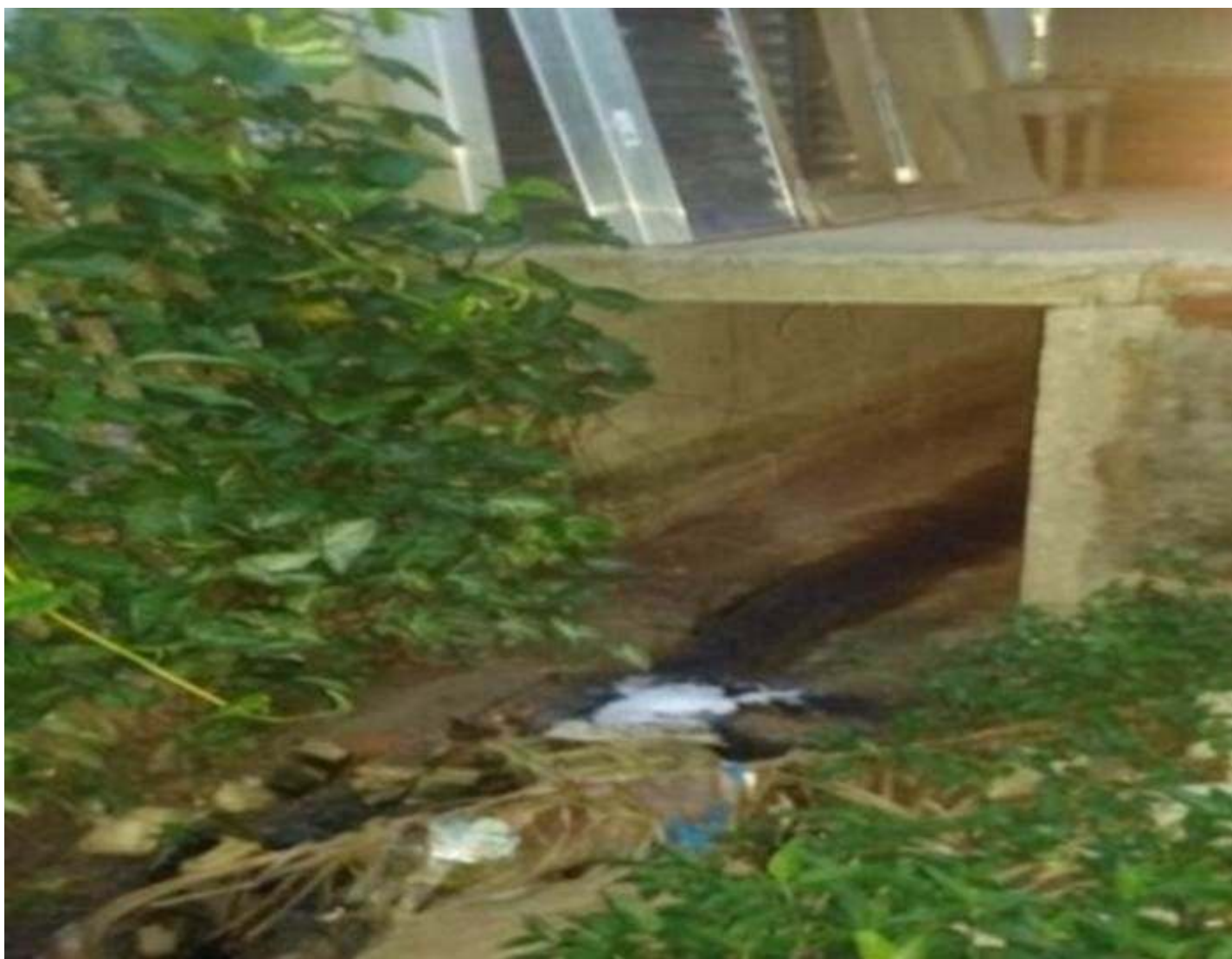
Figura 9: Canaleta construída por morador
