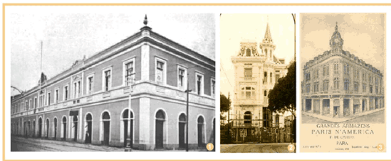
Figura 5: 1) Cartão-Postal da Fachada do Mercado de Ferro; 2) Palacete Bolonha em construção em 1904, fotografia de Theodoro Braga e 3) Cartão-Postal da loja Paris n'América. Fonte: 1) Acervo do arquivo público do estado - Belém da Saudade, 1996. 2) https://www.facebook.com/nostalgiaabelm/photos_stream . 3) Acervo do arquivo público do estado - Belém da Saudade, 1996.
