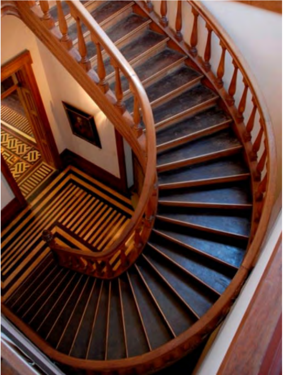
Figura 73. Vista da escada e pisos em madeiras nobres, rico trabalho de marchetaria. Fotografia: Patrick Pardini.
