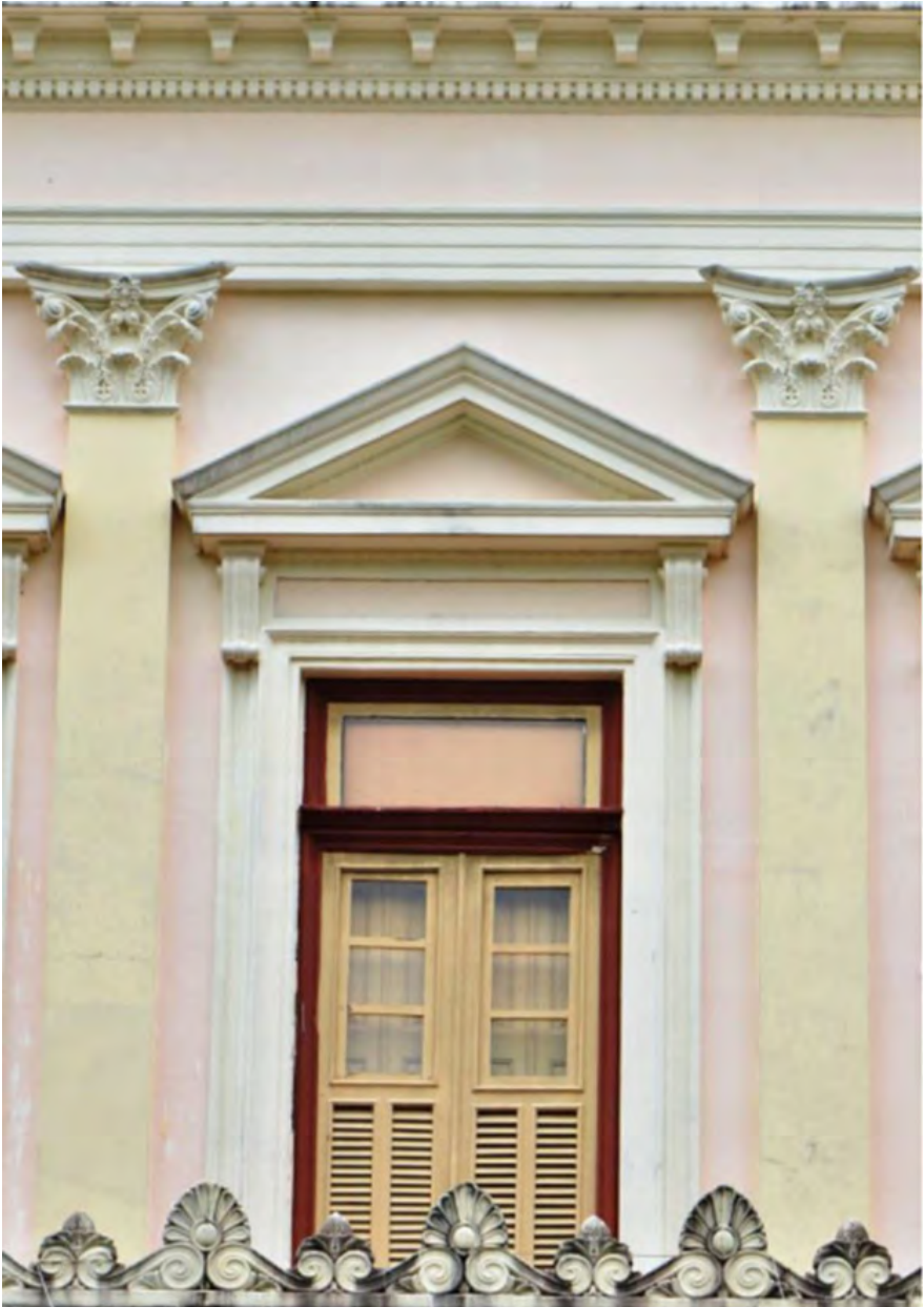
Figura 70. Detalhes da arquitetura em estilo eclética. Fotografia: Valério da Silveira.
