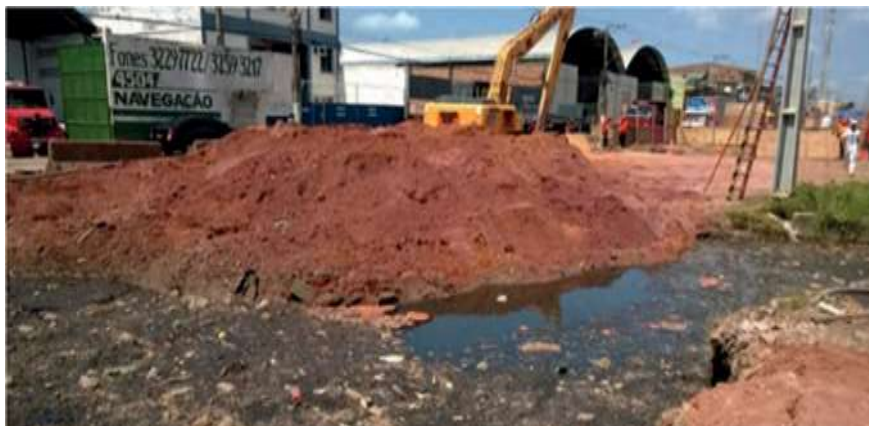
Figura 13: Obras de aterramento do Canal da Bernardo Sayão. Bacia da Estrada Nova
