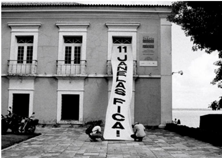
Figura 3. Detalhe da fachada do museu e a faixa do Movimento. Fonte: Facebook do “Movimento Casa das Onze Janelas”.
