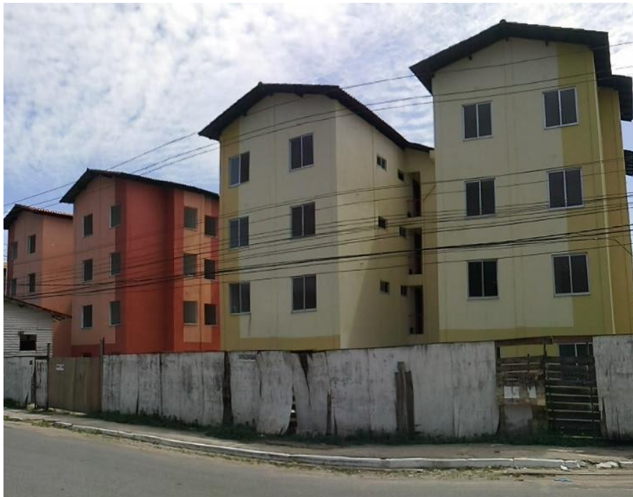
Fonte: MALHEIROS, 2017. Av. Perimetral.
