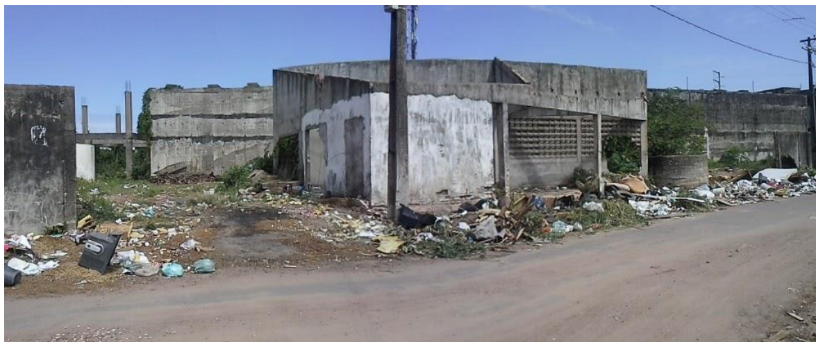
Fonte: MALHEIROS, 2017. Estação de Tratamento de Esgoto (ETE) abandonada.
