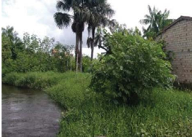
Figura 5. Construção à margem direita do igarapé Garrafão, Rua Carlos Gomes
