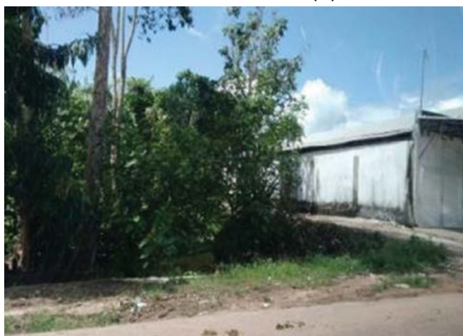
Figura 4. Construção à margem esquerda do igarapé Garrafão, Av. 7 de Setembro (b)
