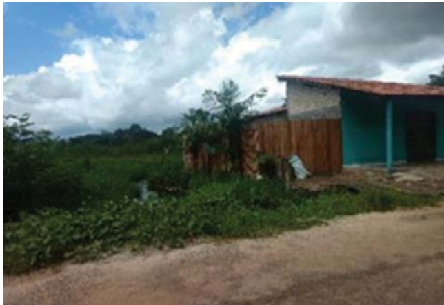
Figura 6. Construção à margem esquerda do igarapé Garrafão, Rua Carlos Gomes
