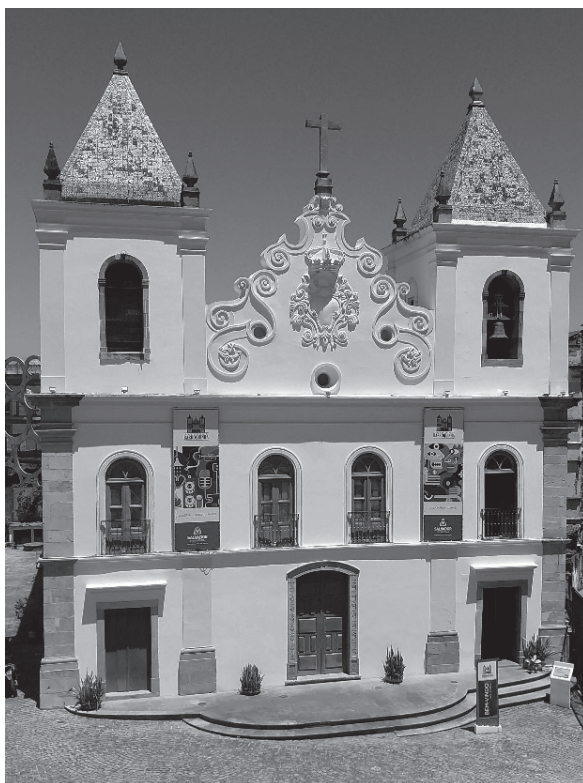
Figura 1 - Espaço Cultural Barroquinha, após obra requalificação urbana
