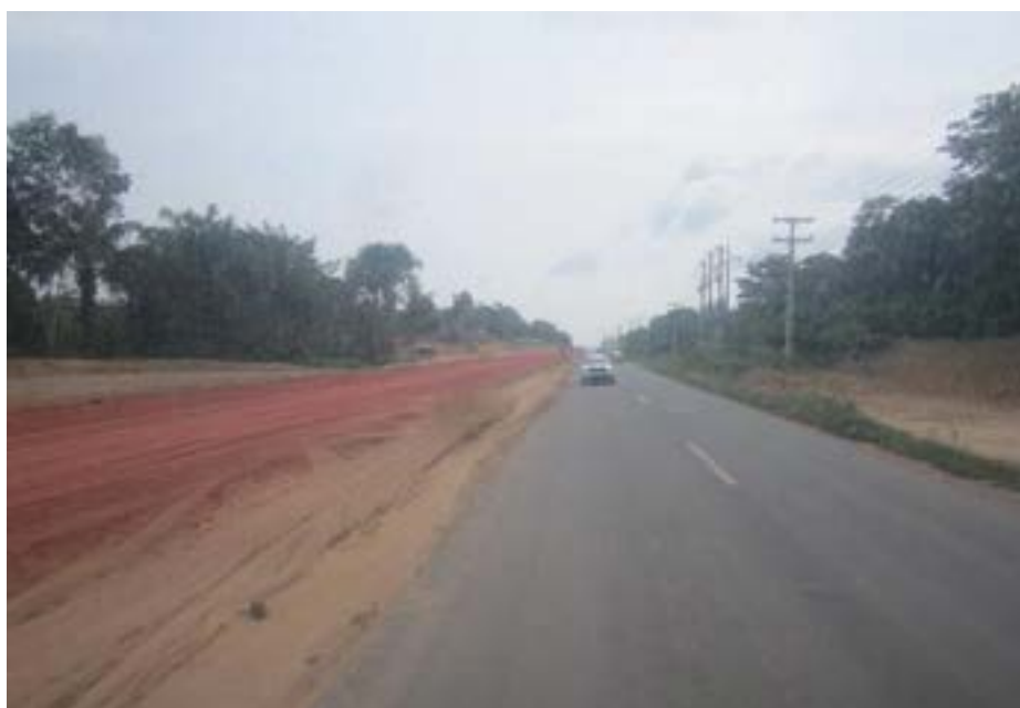
Figura 3 – Obra de duplicação da rodovia Manoel Urbano - AM – 070.
