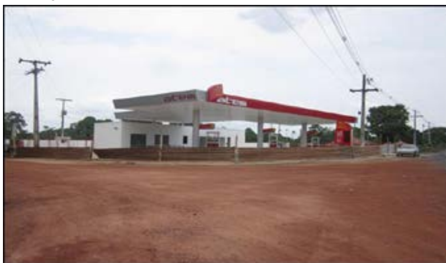
Figura 5 – Posto da bandeira ATEM em construção na AM – 452.
