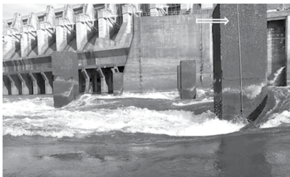
Figura 3. Corda utilizada para a pesca no pé da barragem, no período de verão.
