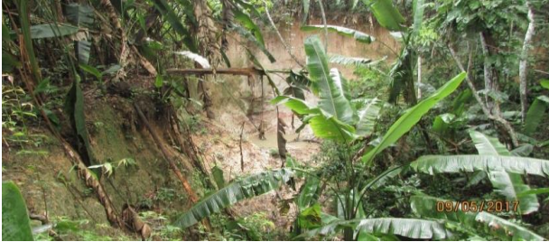
Figura 1: Intensa erosão pela infiltração da água no subsolo.
